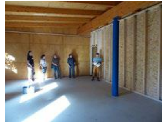
Besprechung im zukünftigen Boulderraum am 13. September 2022
