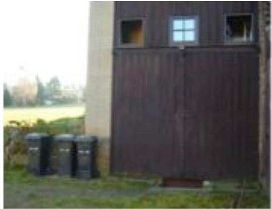
Rechte Seite = Kellereingang
