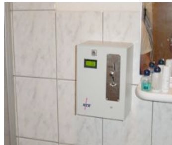
Münzzähler für Dusche – Einwurf 50 Cent = 15 Liter heißes Wasser Verbrauchs- und nicht zeitabhängig
